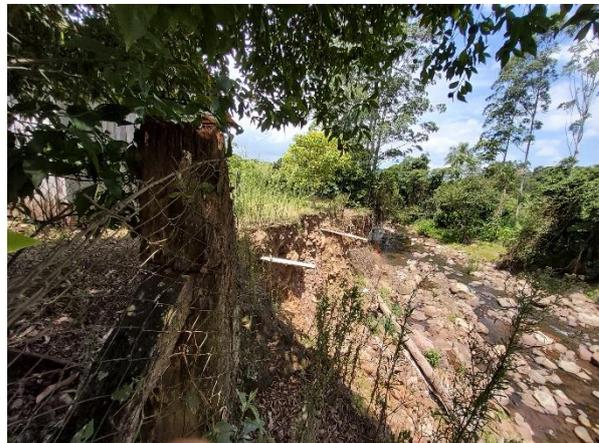
Figura 17 – Erosão fluvial da margem do arroio, expondo tubulações de lançamento de água servida em seu leito. Alto Cerro Branco, setor RS\_CERROBR\_SR\_08\_SGB.
