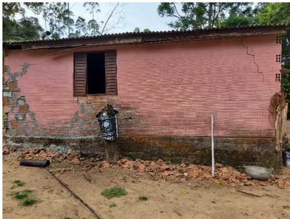
Figura 7- Casa com rachaduras, devido ao deslizamento da encosta. Linha Santo Antônio, setor RS\_CERROBR\_SR\_03\_SGB.
