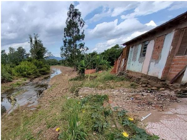
Figura 14- Casas situadas na margem do Rio Botucarai, que foram danificadas com o solapamento da margem, causado pela erosão fluvial. Alto Cerro Branco, setor RS\_CERROBR\_SR\_15\_SGB.
