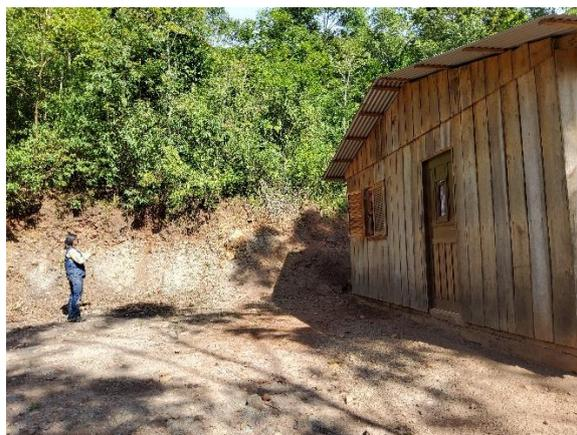
Figura 11- Casa recém construída no modelo corte/aterro sobre encosta declivosa. Observa-se o risco de deslizamento potencializado pela intervenção na encosta com o corte do talude. Linha Alta, setor RS\_CERROBR\_SR\_14\_SGB.
